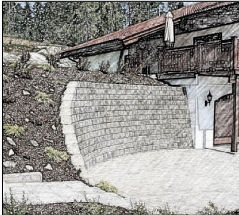
Exemples de soutènements maçonnés
