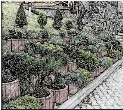
Exemple de soutènement végétalisé
